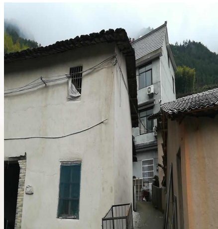
赤膊墙改造后
