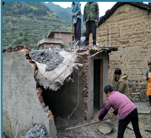
猪栏旱厕拆除
