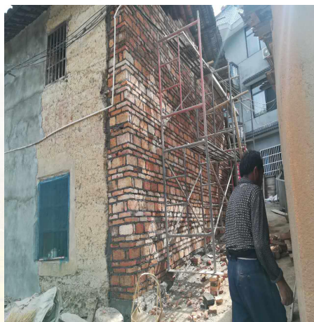
赤膊墙改造前
