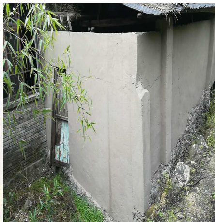
赤膊墙改造后
