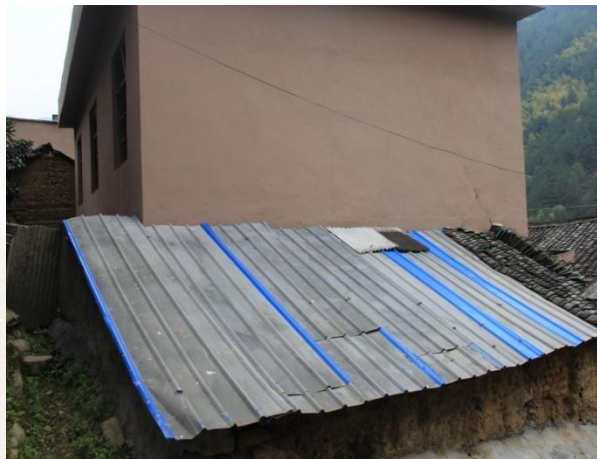
蓝顶棚改造前
