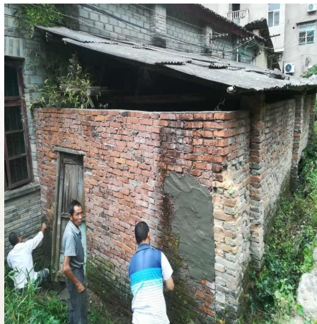
赤膊墙改造前
