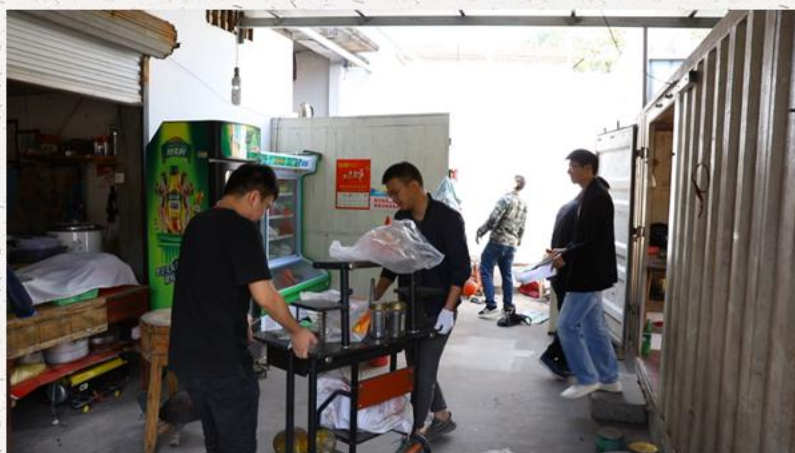
拆除违章建设9000平方米
