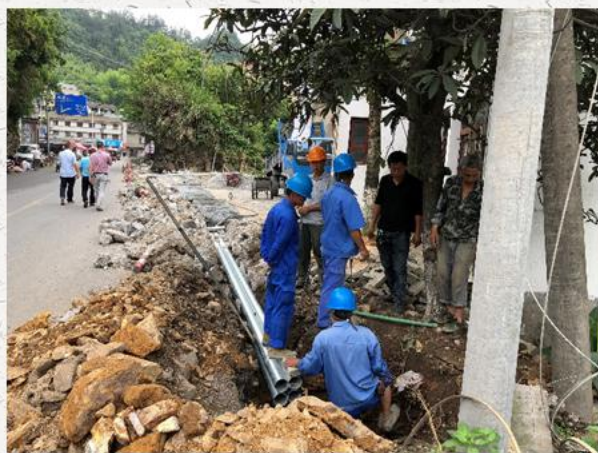
线路上改下1620米 杆路整治、序化4.5公里
